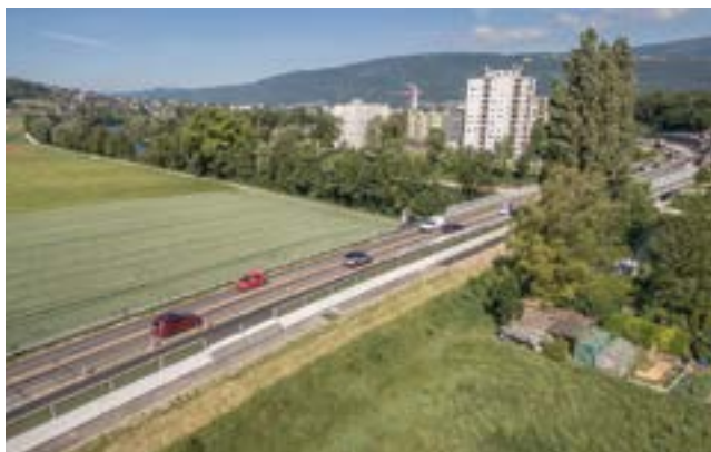
Montagevorbereitung Lärmschutzwände (Fahrtrichtung Biel)
