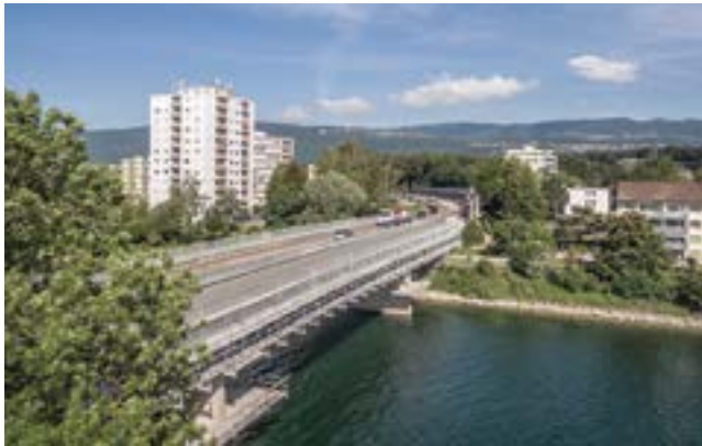
Sanierung Brücke Nidau-Büren-Kanal (Blickrichtung Biel)
