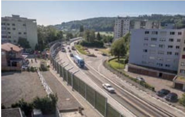
Lärmschutzwände (Blickrichtung Lyss)
