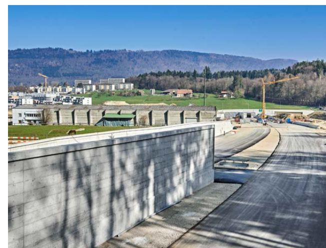
Im Spätsommer 2017 soll der Ostast gemeinsam mit dem Vollanschluss Orpund dem Verkehr übergeben werden.
