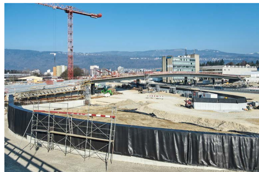
Die rund 180 Meter lange Brücke der Mittelstrasse bietet eine effiziente Verbindung zwischen dem Weberpark und dem Centre Brügg und ersetzt die bestehende Ein- und Ausfahrt Brügg.
